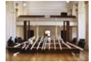
2018 baute Juri Troy eine schräge Ebene in die Barockkapelle des Konservatoriums, indem er die bestehenden Kirchenbänke als Unterkonstruktion verwendete.
